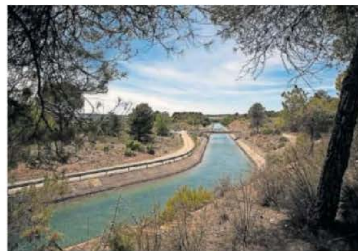
Canal del trasvase Tajo-Segura a su paso por Albacete. L. SEVILLANO
